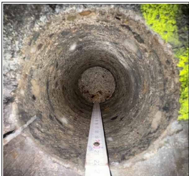
Protokoll ProAn Bild 33: Aufnahme Bohrkernloch.
