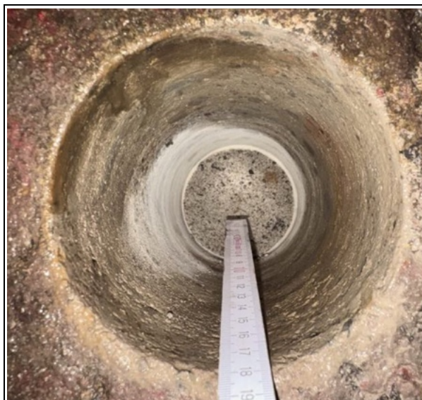
Protokoll ProAn Bild 14: Aufnahme Bohrkernloch.
